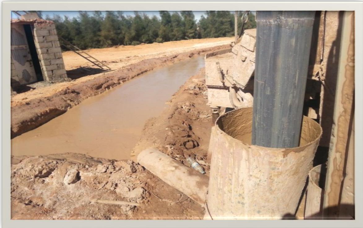
شكل (16) يوضح تنمية وتنظيف البئر بالشفاط
