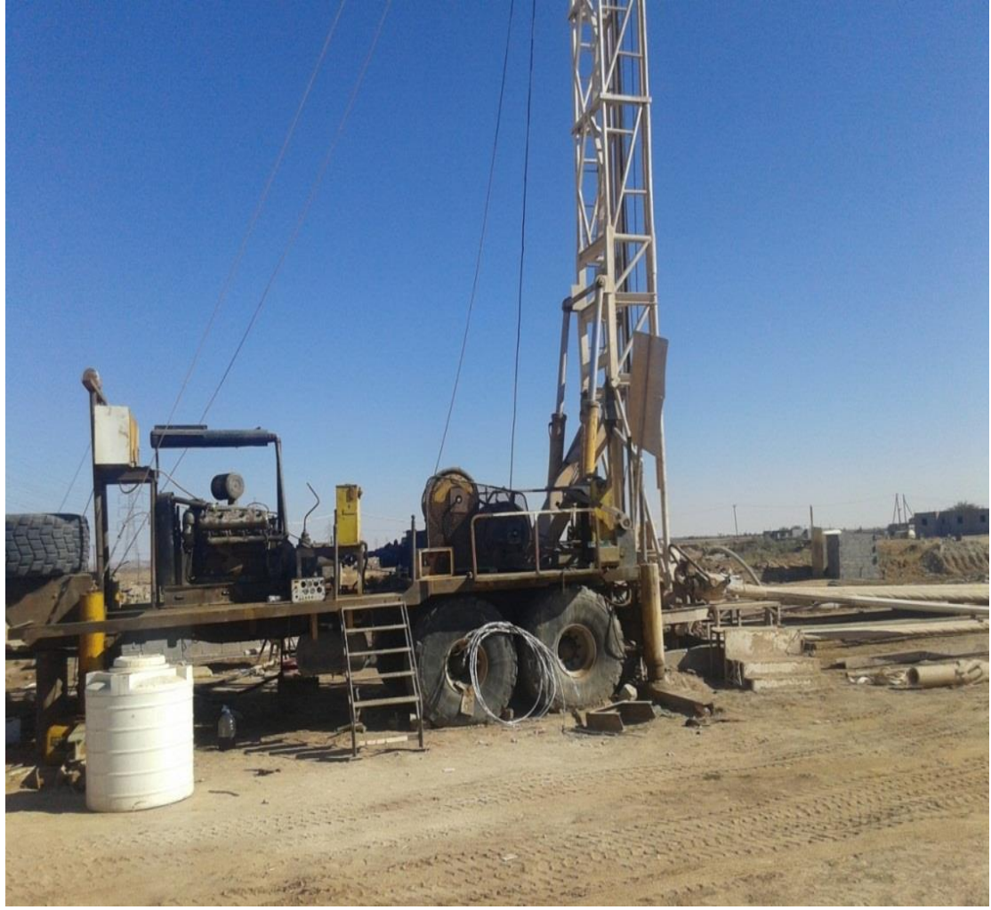
شكل (10) يوضح طريقة الحفر بالدوران الرحوي
