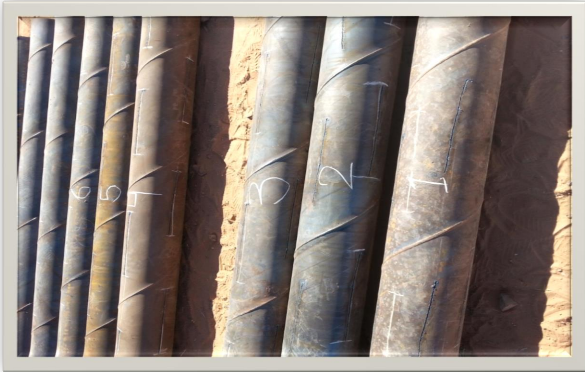
شكل (15) يوضح إنزال أنابيب الإنتاج (المخرمة) بقطر 10 بوصة
