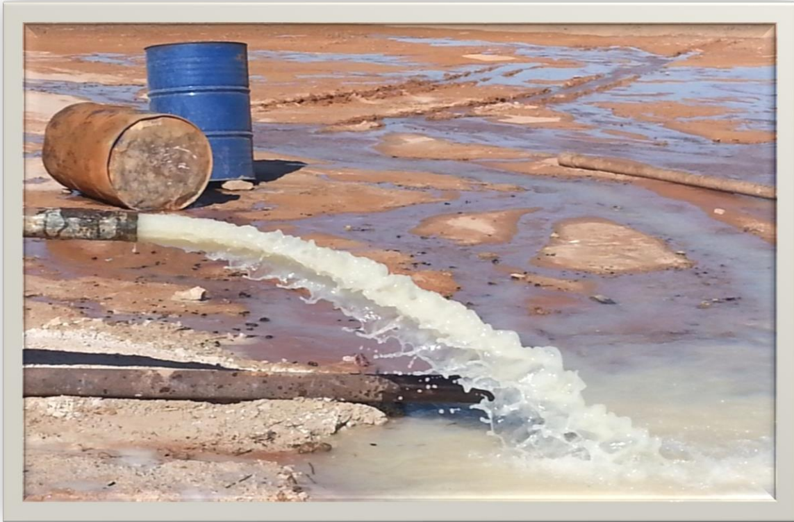
شكل (17) يوضح تنمية وتنظيف البئر بواسطة المضخة الغاطسة
