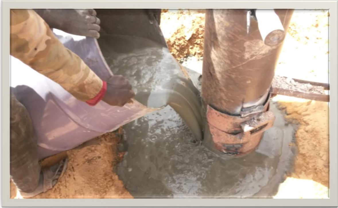
شكل (13) يوضح إنزال أنابيب التغليف وعمل الحلقة الإسمنتية
