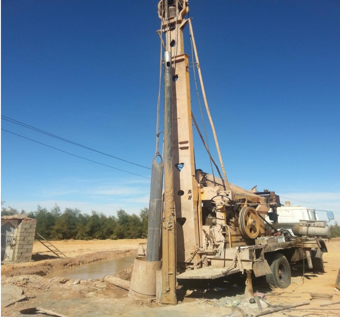
شكل (9) يوضح طريقة الحفر بالآلة الدقاقة
