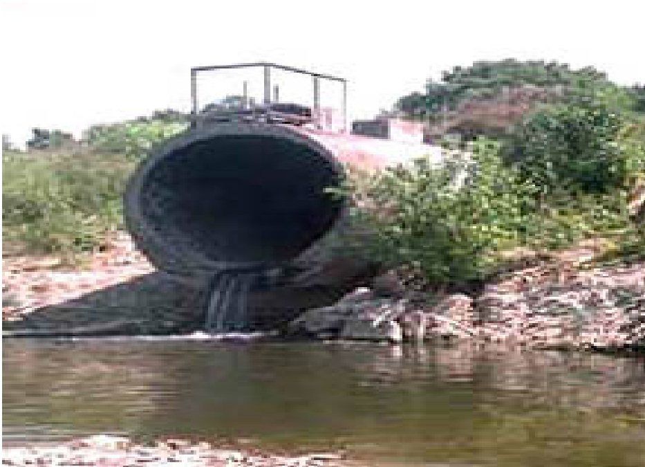
شكل (8) يوضح التلوث المائي الناتج من صرف مياه المجارى فى مياه القنوات المائية المسخدمة فى رى الأراضى الزراعية
