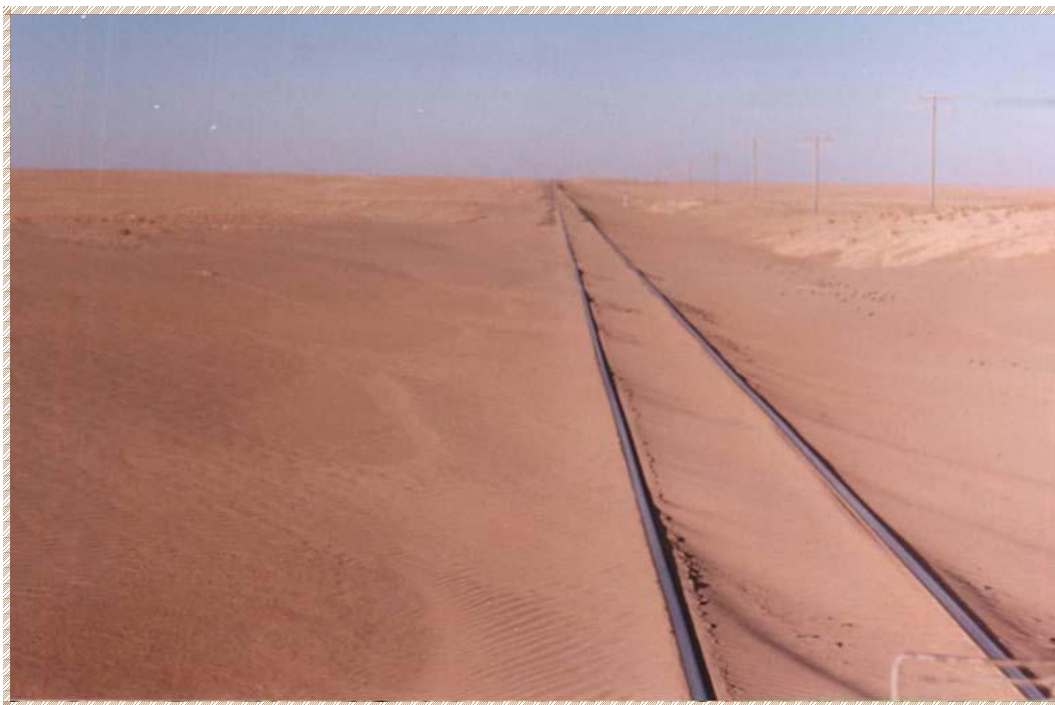
شكل رقم ١٩/. تجمع الرمال على الخطوط الحديدية
