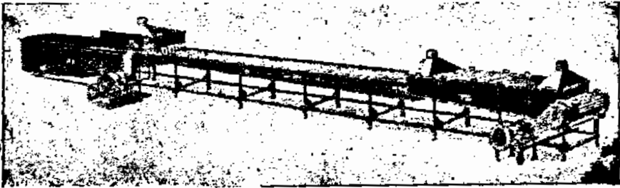
(شكل ٧٦) ماكينة غسل ثمار الطماطم وتسخينها
