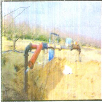
وحدة ترشيح شبكية ( فلاتر الشبكة ) ( Screen Filters ) تستخدم لمياه الآبار الارتوازية
