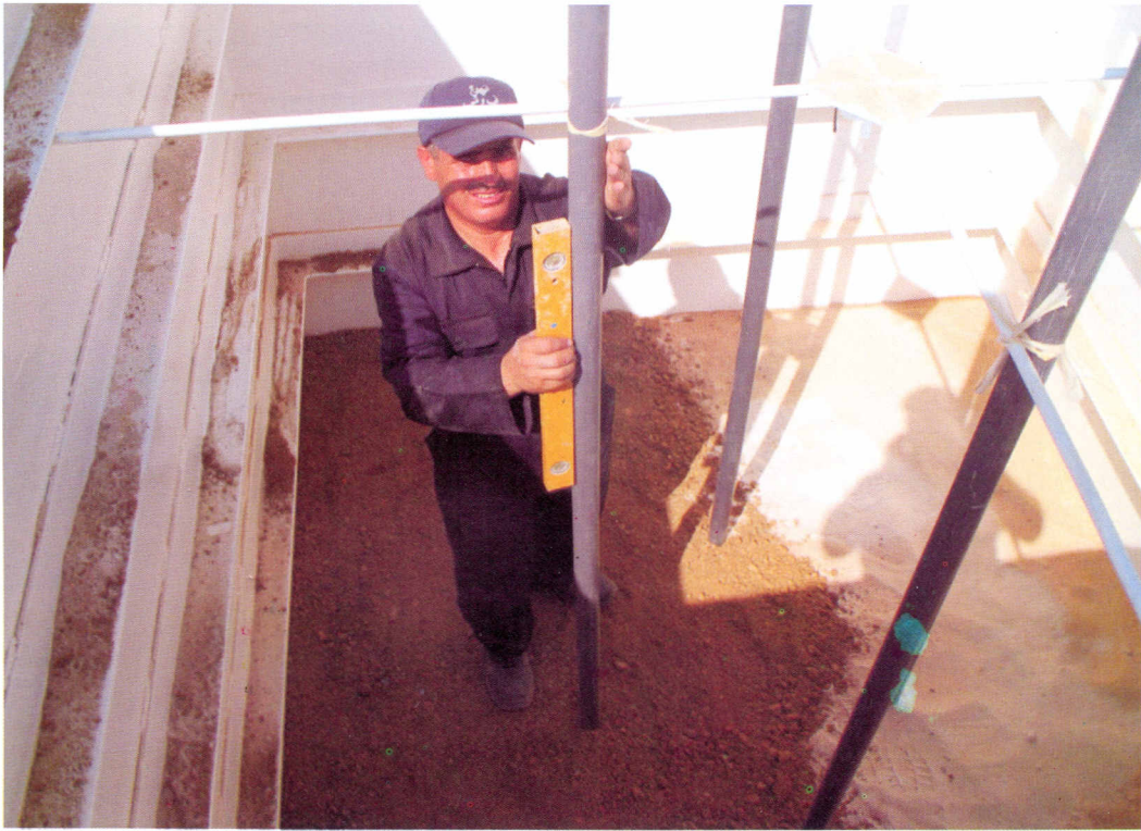
شكل (١١) اعادة وضع التربة على طبقات وتركيب انابيب لقياس رطوبة التربة
