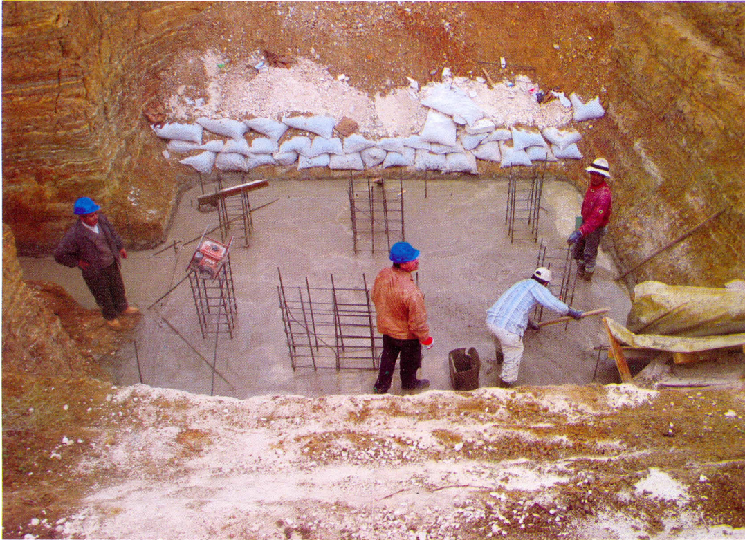
شكل (٧) عمل قاعدة اسمنتية لوضع ميزان اللايزوميتتر
