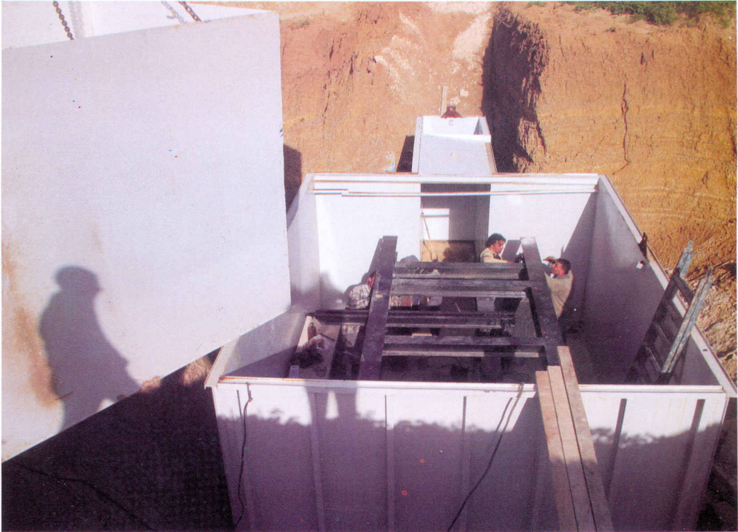
شكل (٨) وضع الهيكل الخارجي للايزوميتر
