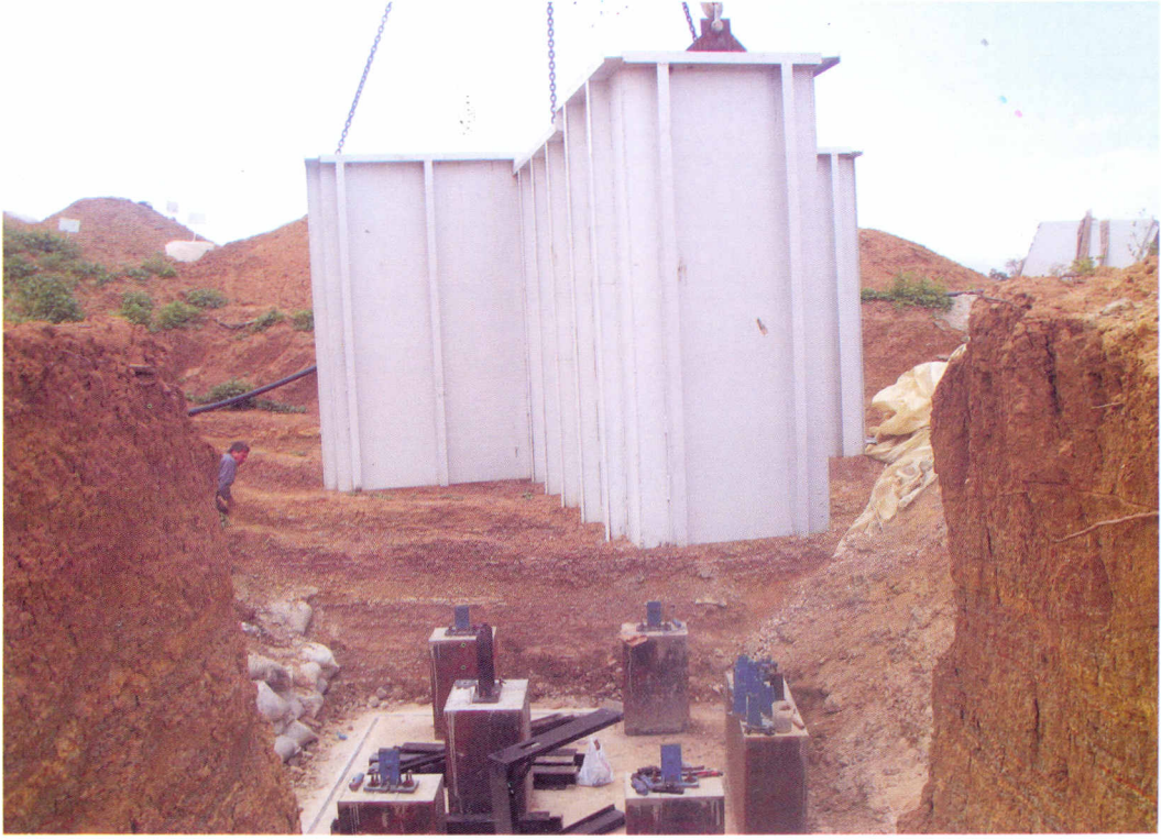
شكل (٨) وضع الهيكل الخارجي للايزوميتر
