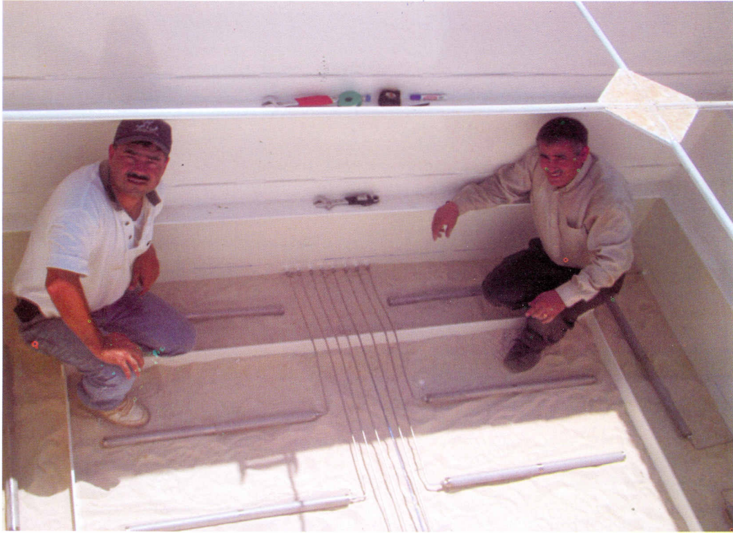
شكل (١٠) تركيب جهاز الصرف للايزوميتر
