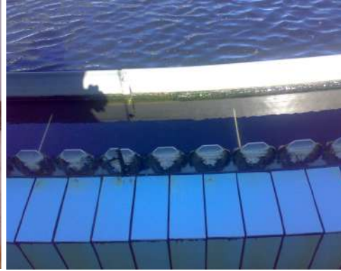
الشكل (11 - 6 - 1 - 5) هدار خروج الماء بشكل v
