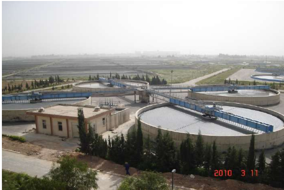
الشكل (2-1-5-25) محطة معالجة مياه الصرف بعدرا المكثفات وساحات التجفيف
