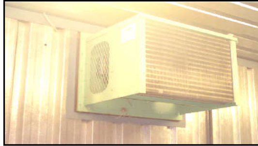
شكل رقم (٢٥٦) يوضح جهاز تكييف داخل غرفة حفظ البيض
