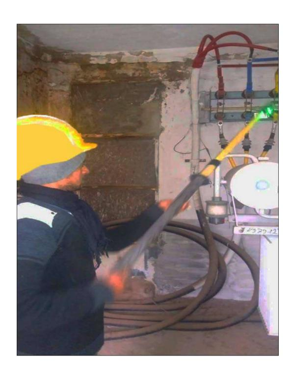
2- التأكد من وجود بطارية بالجهاز قبل الاستخدام 3- اختيار الكاشف على وضع الاختبار (test) 4- تثبيت الكاشف على العصا الخاصة به 5- امساك العصا بطريقه صحيحة من اليد المخصصة لذلك مع فرد العصا حتى النهايه (طولها 1.5 متر للكاشف الداخلي و 2 متر للخارجي) للتجنب من الدخول في منطقة الخطر
