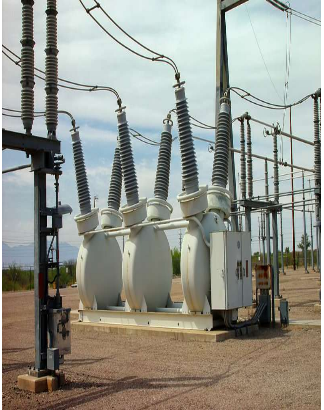
قاطع تيار سادس فلوريد الكبريت خارجي
