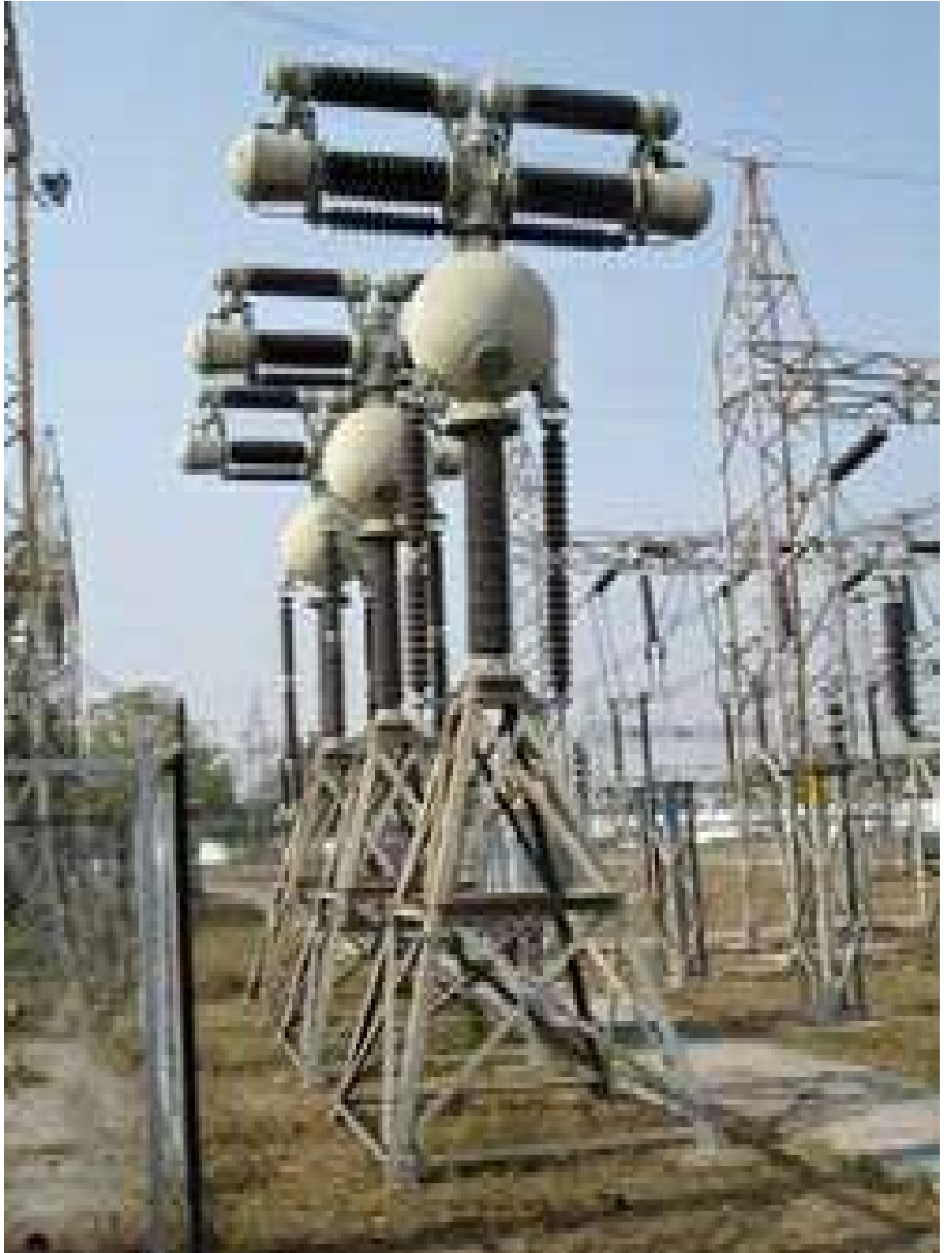
قاطع تيار دفع هوائي خارجي
