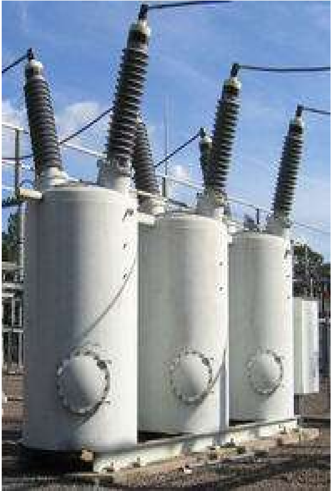
قاطع تيار الزيت المنخفض الخارجي
