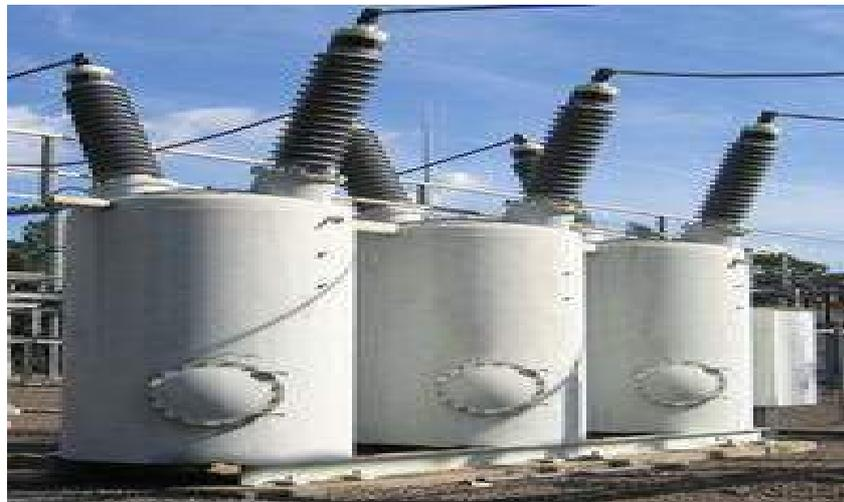
قواطع غير زيتية ( Oil Less Circuit Breaker ) تعتبر القواطع غير الزيتية من أكثر الأنواع استعمالا في التطبيقات الداخلية ( Indoor ) وتستخدم هذه القواطع عند الجهود التي يتراوح قيمها ما بين ( 800KV - 1KV )، و تعتمد في استعمالها على الهواء المضغوط و غاز سادس فلوريد الكبريت من المحطات الخارجية عند الجهود من ( 34.5KV - 362KV ).
