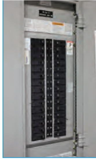
▲ تحمي القواطع الدارات من التيار الزائد.
