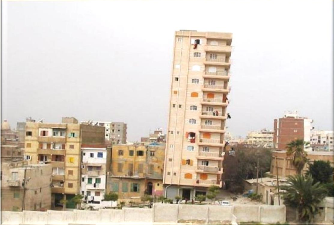
وهذا احدى ميل العمارة في (اسكندريه - مصر) بسبب هبوط في التربه والامر بيد الله
