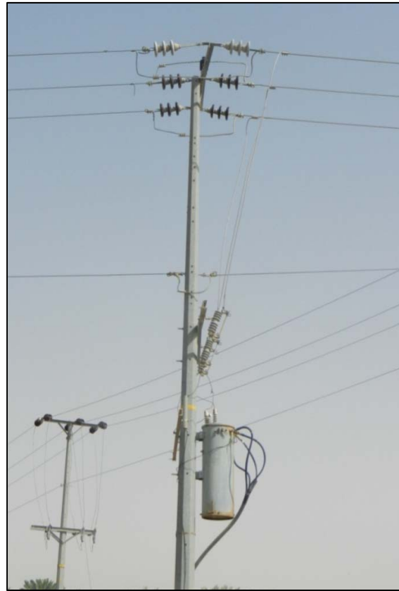
شكل (١ - ٢٦) - أبراج تثبيت 13.8 kV على خط نقل كهربائي
