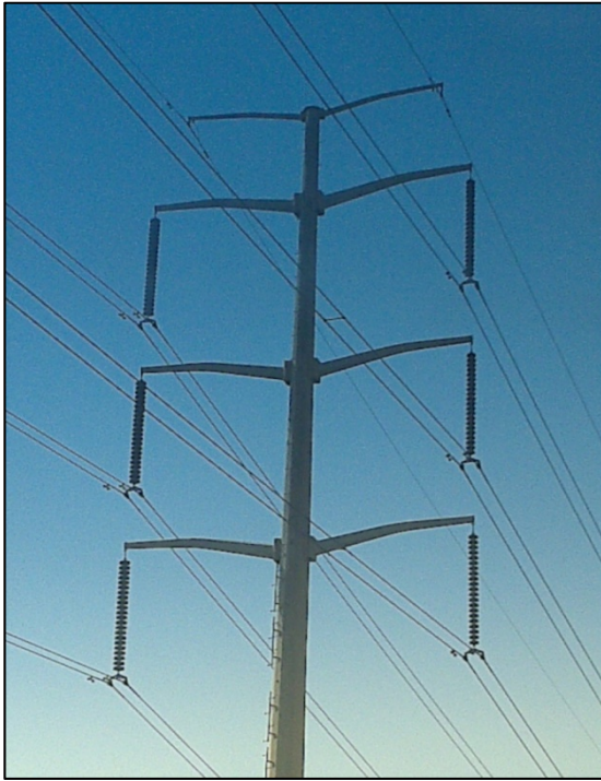
شكل (١ - ٢٥) - الأعمدة الخرسانية 115 kV
