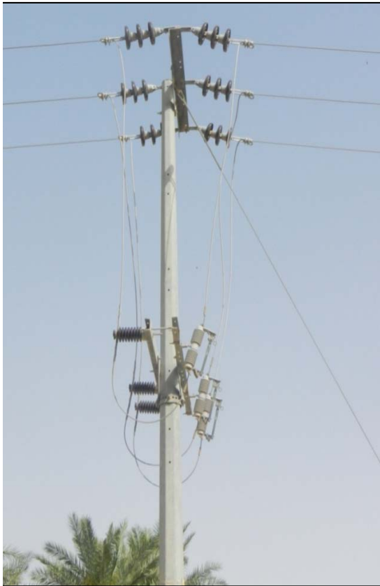
شكل (١ - ٢٦) - أبراج تثبيت 13.8 kV على خط نقل كهربائي
