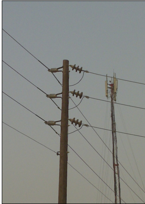
شكل (١ - ٣١) - برج الزاوية لخط نقل كهربائي 13.8 kV
