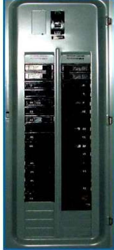
لعمل القواطع على حماية الدوائر الكهربائية من التيارات الكبيرة.
