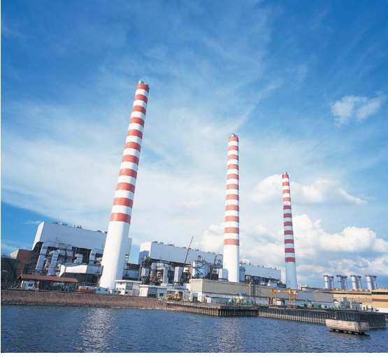
شكل 6 - 17 محطة قدرة لتوليد الكهرباء
