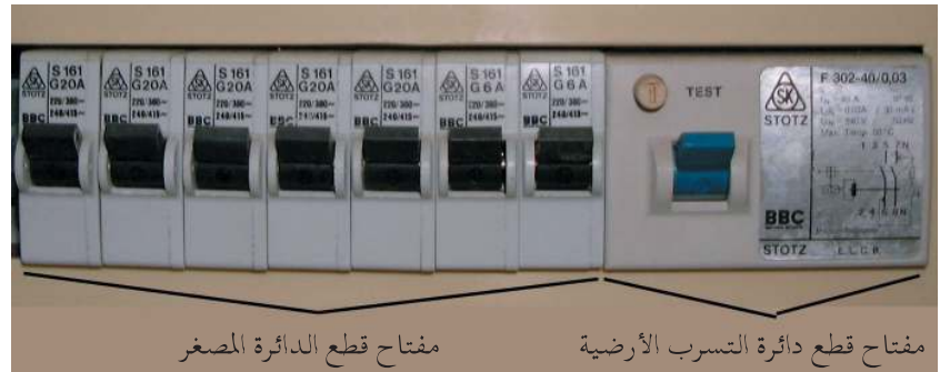
شكل 4 - 27 قاطع دائرة وحدة التوزيع المنزلية
