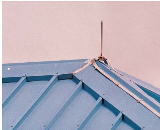
شكل 1 - 36 يمنع مانع الصواعق أي تلف محتمل لبناية خلال العواصف الرعدية.
