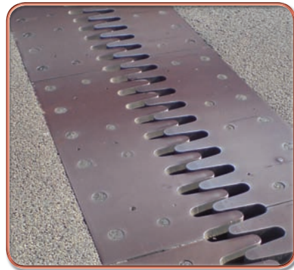
شكل (٣٥): لماذا توجد مسافات فاصلة فى الجسور والكبارى؟
