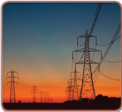
شكل (٣٦): لماذا تكون الكابلات الكهربائية غير مشدودة؟
