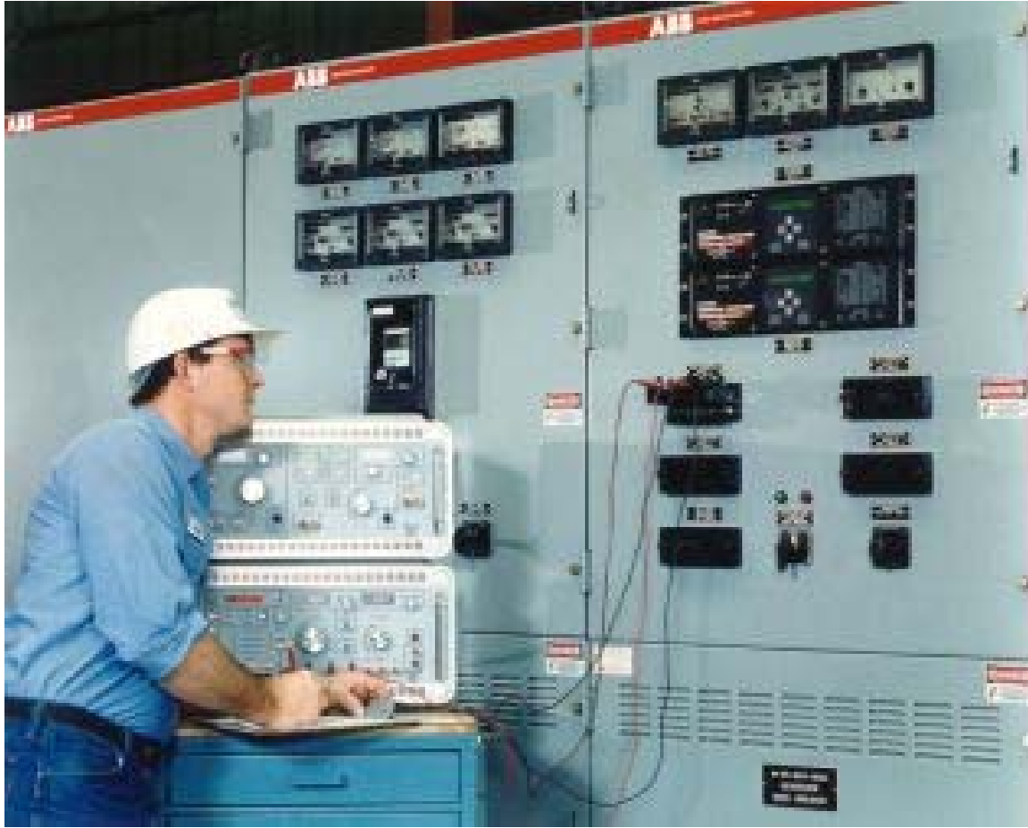
شكل (٢- ١٧) - اختبار مرحلات الحماية في محطات التحويل .
