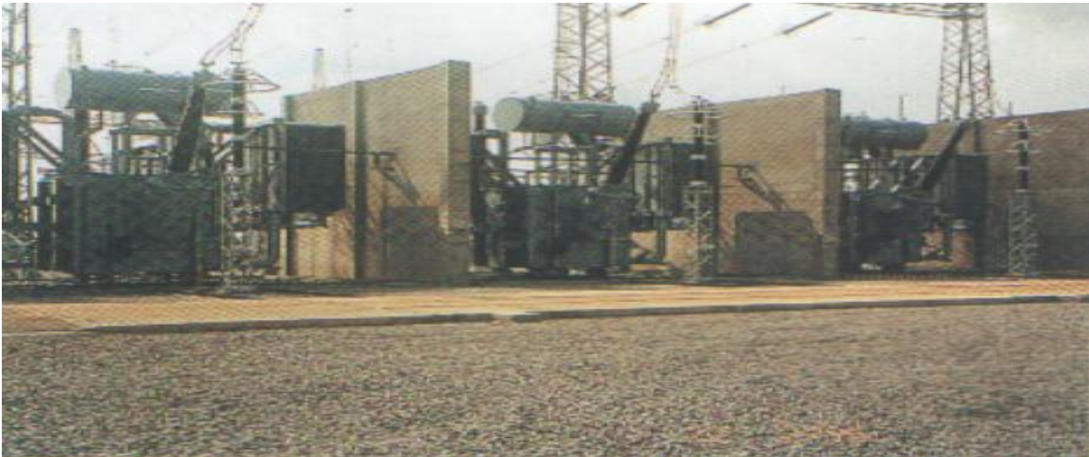
شكل (٢ - ٦) - اعتبارات تركيب المحولات المغمورة في الزيت .
