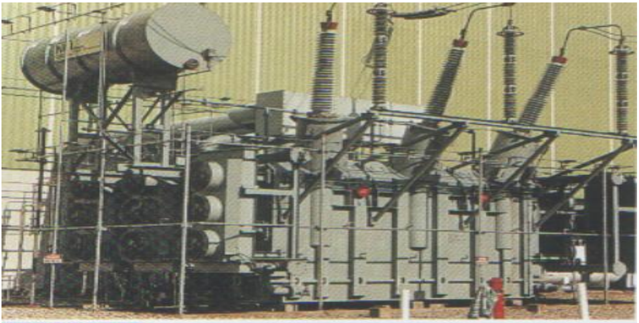
شكل (٢ - ٧) - بعض أنواع المحولات المغمورة في الزيت .
