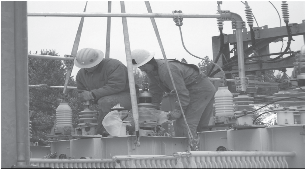
شكل (٢- ١٩) - نماذج لبعض العوازل المستخدمة في محطات التحويل .
