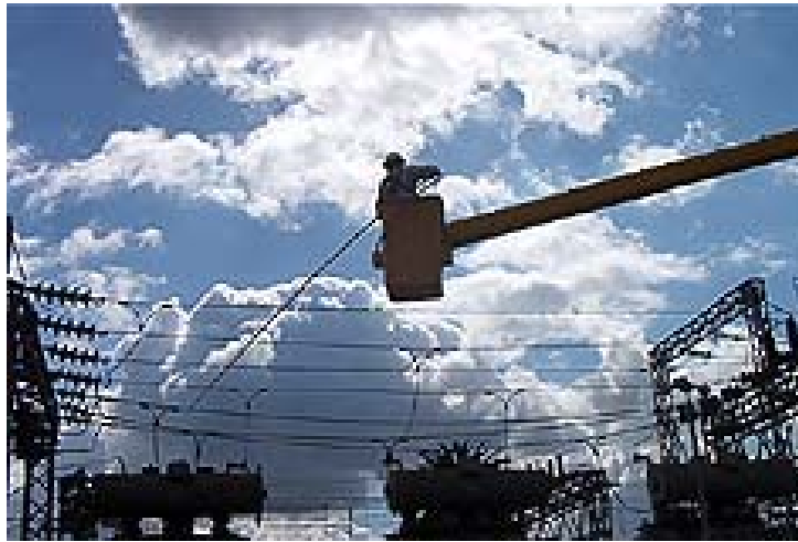
شكل (٢- ١٨) - فحص وتنظيف قضبان التوزيع في محطات التحويل .
