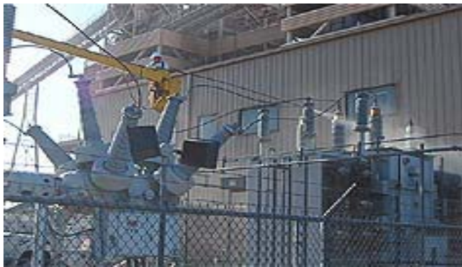
شكل (٢- ٢٠) - طرق تنظيف عوازل محطات التحويل .
