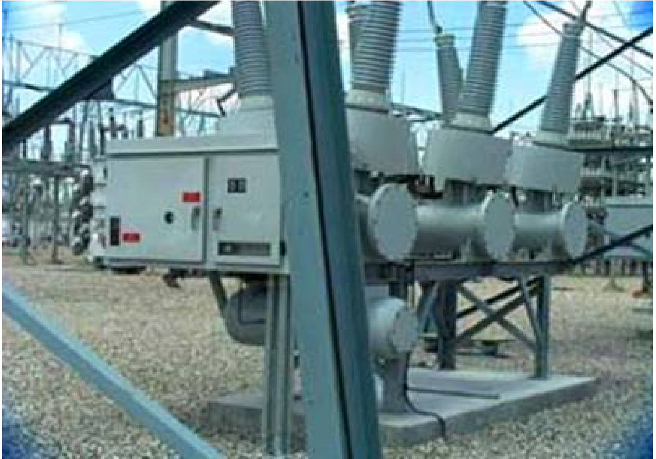
شكل (٢- ١٠) - الشكل العام للقواطع الزيتية .
