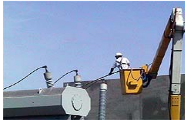
شكل (٢- ٢٠) - طرق تنظيف عوازل محطات التحويل .
