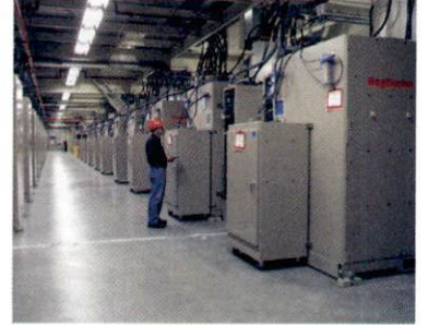
الشكل 4.21 ثمانية وأربعون وحدة لتكبير القدرة في إحدى الحجرات الأربع في منشأة الإشعاع الوطنية في مختبر لورانس ليفرمور الوطني.
