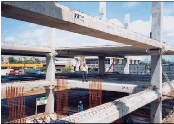
شكل(1) يوضح وحدات الأعمدة والكمرات التي تكون الهيكل الإنشائي للمبنى
