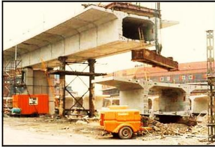
خرسانة سابقة الصب في الموقع Site Precast
