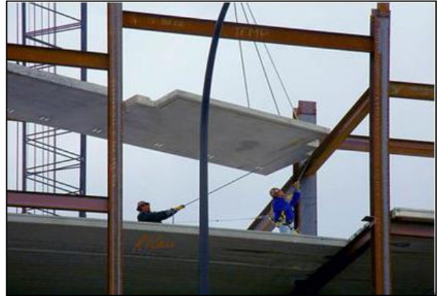
شكل(1) يوضح وحدات الأعمدة والكمرات التي تكون الهيكل الإنشائي للمبنى
