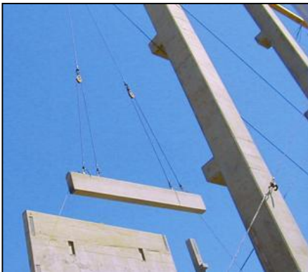
شكل(2) يوضح الأعمدة المتصلة التي تكون بأرتفاع المبنى
