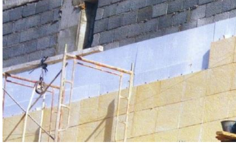
الشكل (1-15) تثبيت العوازل الحرارية على الجدران الخارجية للمبنى
