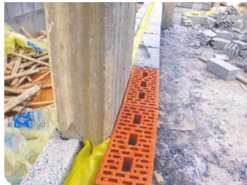
الشكل (14-1) النظام التقليدي: نظام الجدارين المتوازيين
