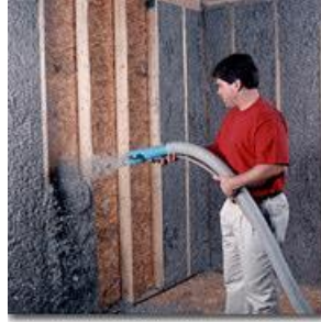
الشكل (3-1) البولي أوريثان المطبق بالحقن
