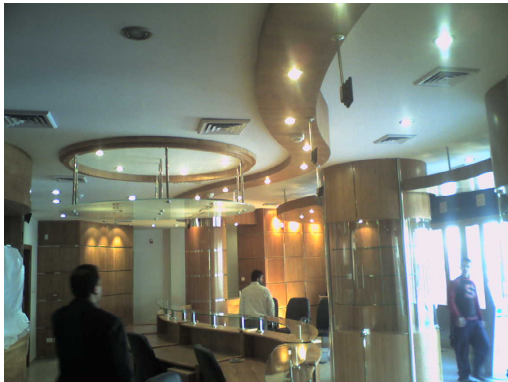
صورة توضح موزعات الهواء Diffusers و جريلات سحب الهواء في منطقة الاستقبال ، بشكل يتناسب و التصميم الداخلي للشركة
