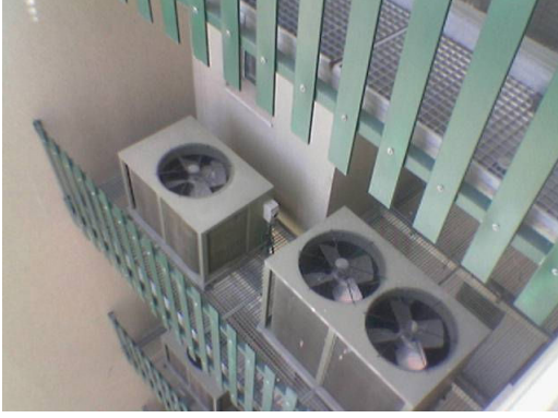
صور توضح الوحدات الخارجية للتكييف ووضعتها خارج المبنى
