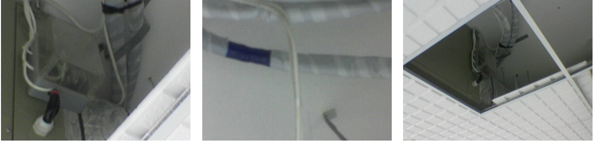
صورة توضح الوحدة الداخلية للتكييف موصول فيها كوابل الغاز التي تصلها بالوحدات الخارجية و تظهر هنا في الصورة الوحدة الداخلية حيث يغطيها السقف المستعار
