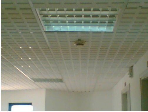
الصور توضح الممر الذي يعلوه السقف المعلق الذي تمتد بداخله جريلات التكييف
