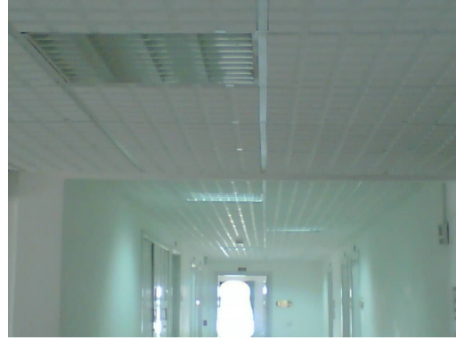
الصور توضح الممر الذي يعلوه السقف المعلق الذي تمتد بداخله جريلات التكييف
