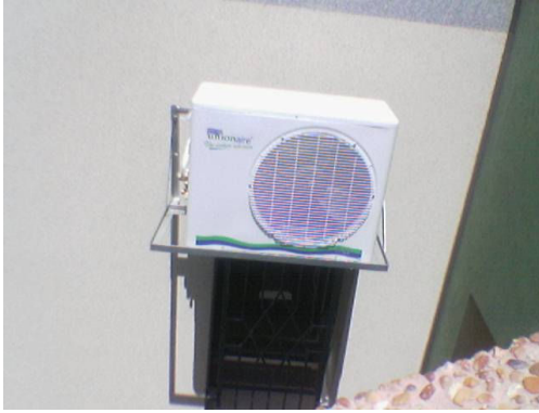
صورة توضح وضعية الوحدات الخارجية وكيفية معالجتها على الواجهة
