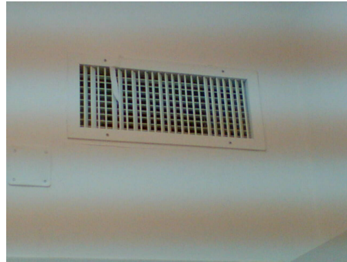
الصور توضح الممر الذي يعلوه السقف المعلق الذي تمتد بداخله جريلات التكييف
