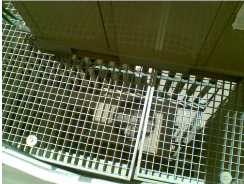
فتح لسحب الهواتبتعد قليلا عن فتحة الضخ
