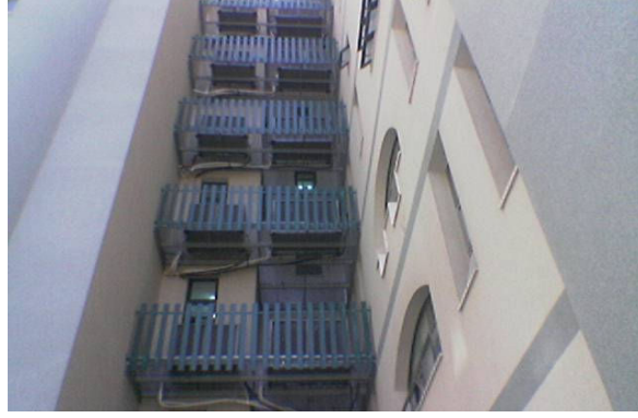
صورة توضح وضعية الوحدات الخارجية وكيفية معالجتها على الواجهة
