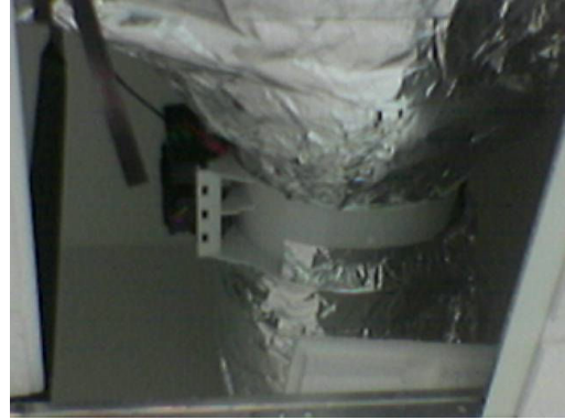
صورة توضح الوحدة الداخلية للتكييف موصول فيها كوابل الغاز التي تصلها بالوحدات الخارجية و تظهر هنا في الصورة الوحدة الداخلية حيث يغطيها السقف المستعار
