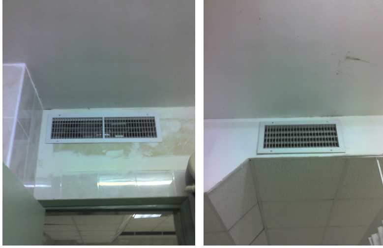
موزع الهواء ( وحدة الحائط ) ٢٠ * ٦٠
