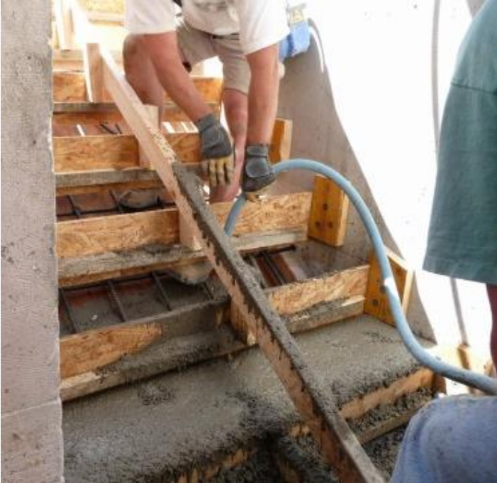
صب الخرسانة فوق الحديد المسلح وداخل الشدات
