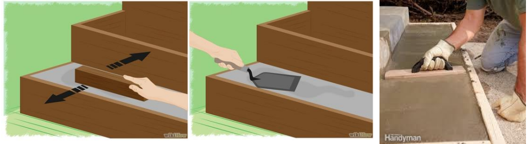
التسوية بمسطرين و التأكد من خروج فقاعات الهواء و عدم وجود بروزات في السطح
