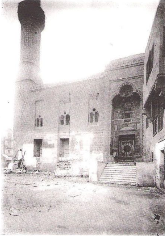
الواجهة الشمالية لمسجد الكيخيا أو عثمان كتخدا (قبل الترميم عن اللجنة)
