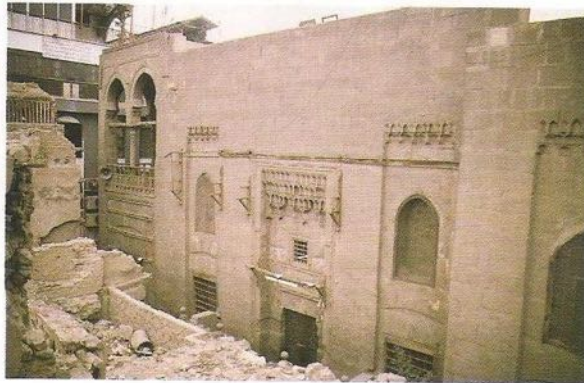
أعلى الواجهة الرئيسية الجنوبية
