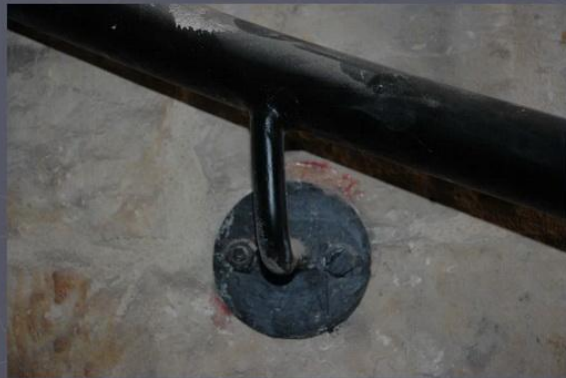
صور توضح طرق تثبيت العמוד بالارضيه و النوائم الحديديه بالعمود و الهاندريل بالحائط
