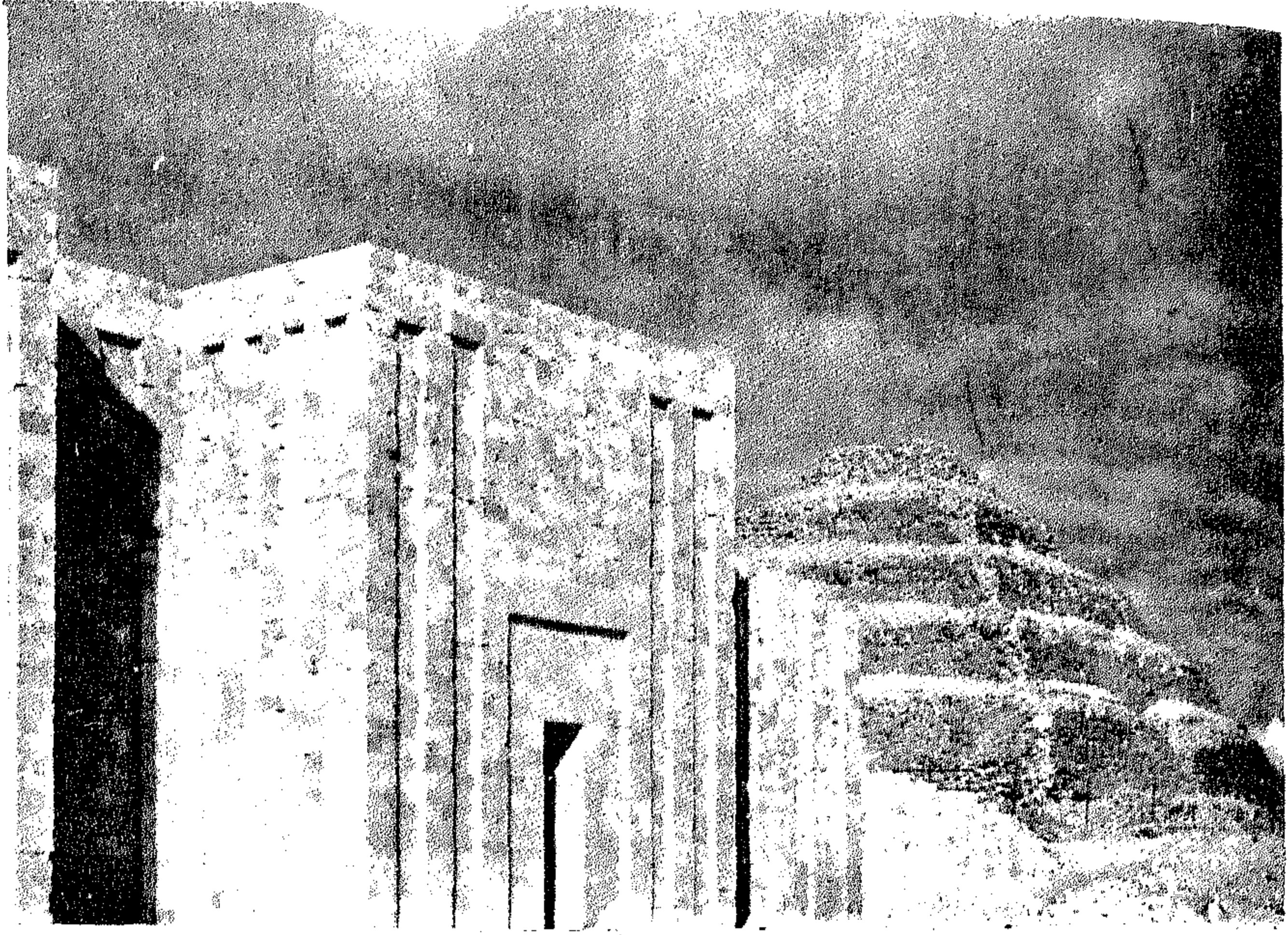
٢ - أ برج المدخل فى النهاية الجنوبية للواجهة الشرقية للجدار الذى يحيط بمجموعة زوسر ( سقارة - الأسرة الثالثة - بعد الترميم ) .
